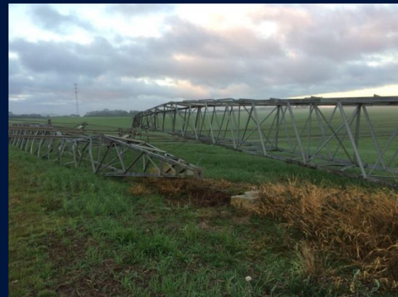
Queda de torre em Otacílio Costa/SC (2018)
